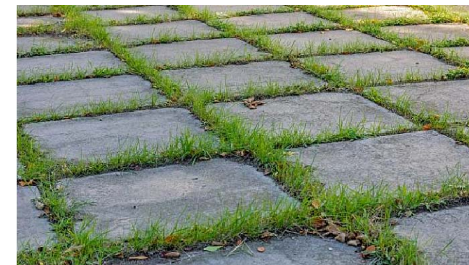
VYMEZENÁ PARKOVACÍ MÍSTA PRO OSOBNÍ AUTOMOBILY, ŽULOVÉ KOČIČÍ HLAVY, ŘÁDKOVÁ POKLÁDKA NA ŠIROKOU ZATRAVNĚNOU SPÁRU
