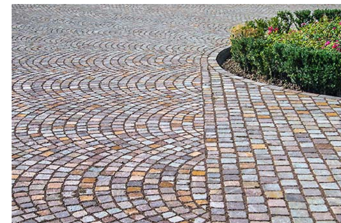
VOLNĚ PŘÍSTUPNÉ KOMUNIKACE, KAMENNÁ DLŽBA ŽULOVÁ, KLADENÁ DO VĚJÍŘE
