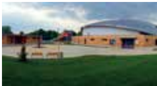
Absolutní prvenství v soutěži Stavba roku Libereckého kraje 2016 získal Sportovní a rekreační areál Maškova zahrada.
