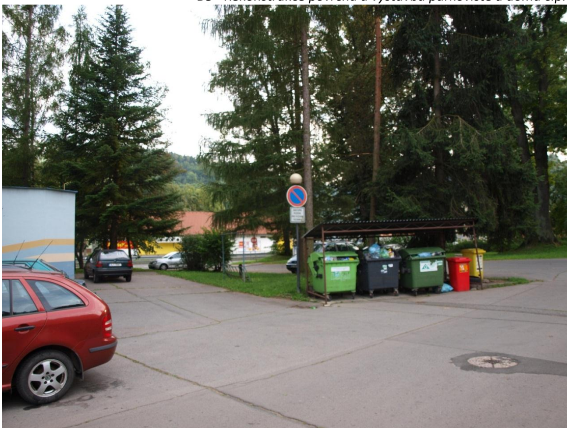
B8 - Rekonstrukce povrchů a výstavba parkoviště u domu č.p. 407
