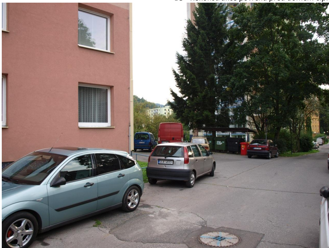
B3 - Rekonstrukce povrchů před domem č.p. 431
