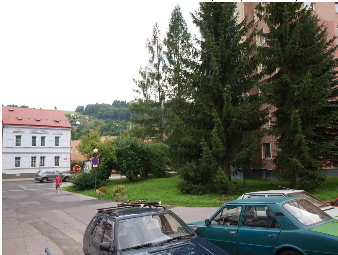
B2 - Výstavba parkoviště na vjezdu do sídliště
