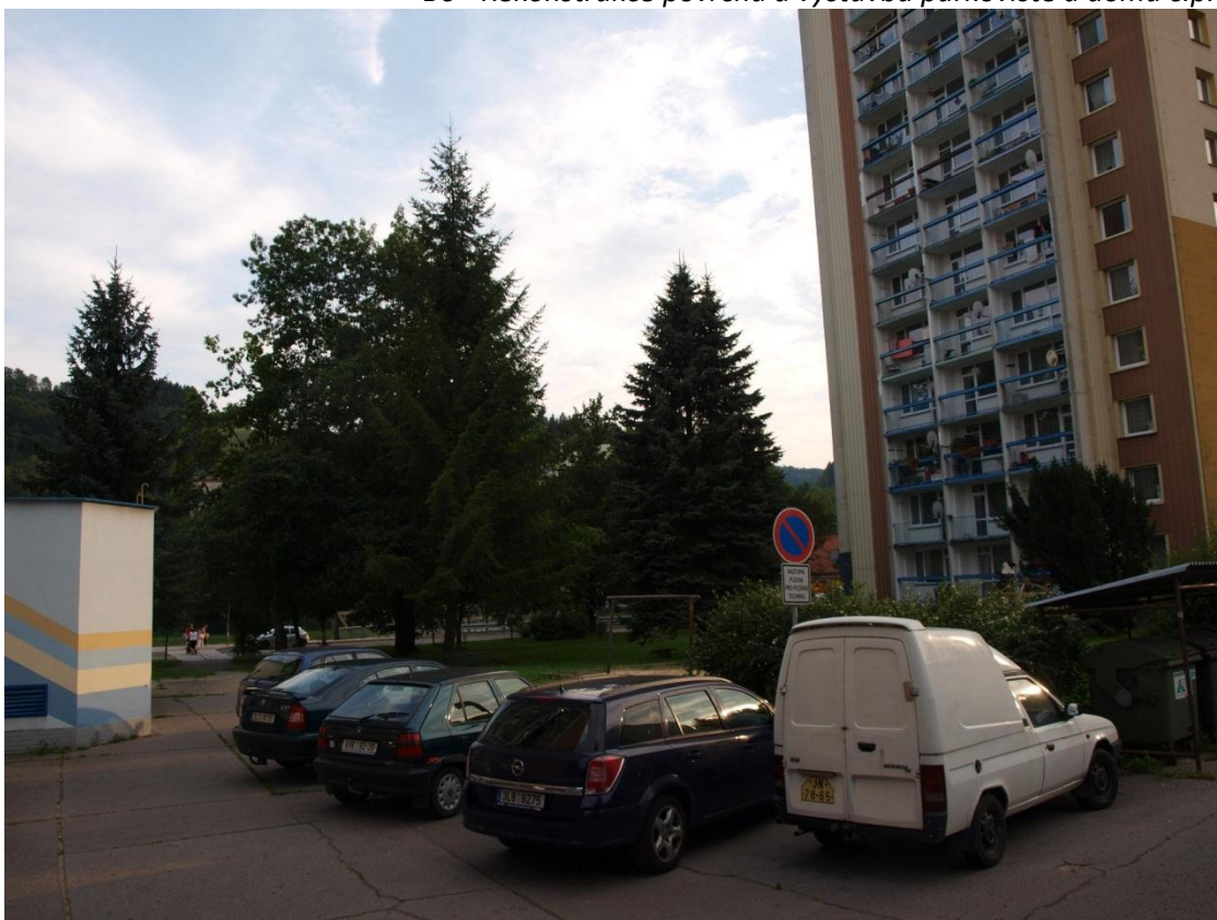
B6 - Rekonstrukce povrchů a výstavba parkoviště u domu č.p. 408
