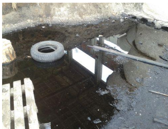
Odpadní voda na podlaze haly
