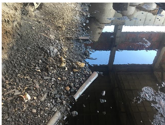
Odpadní voda na podlaze haly
